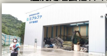
建物の内部左に廃プラが山積み
